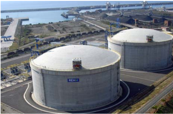
شکل ۲. نمایی از مخازن بتنی ذخیره سازی [۹].
